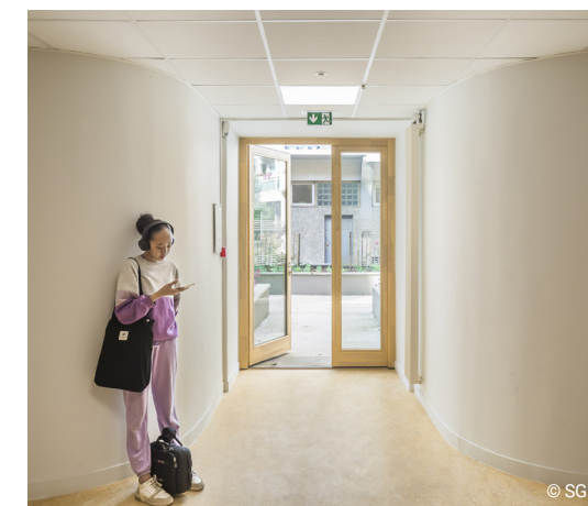
La remise en état intègre de nouvelles baies et portes acoustiques.
