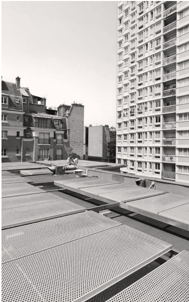
Les brise-soleil déposés
