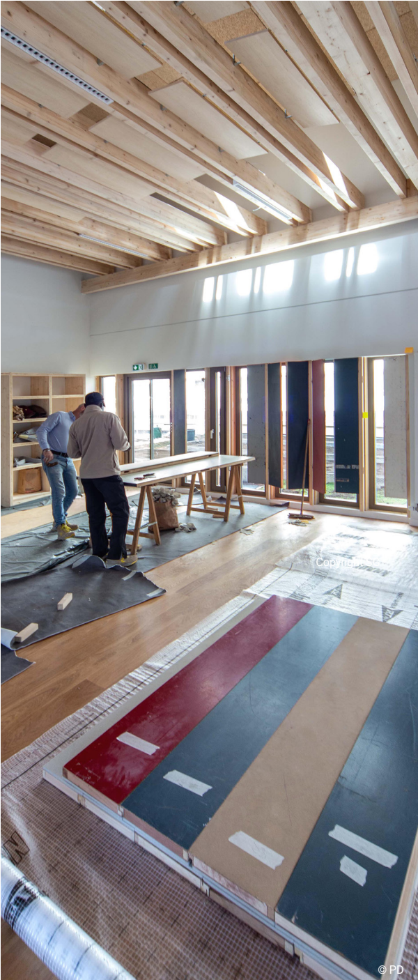
Les portes du rez-de-chaussée sont réutilisées en réflecteurs acoustiques.
