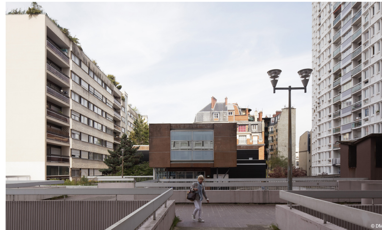
La dalle, très morcelée peine à s'affirmer comme seuil de référence, l'impression de circuler au premier étage domine.
