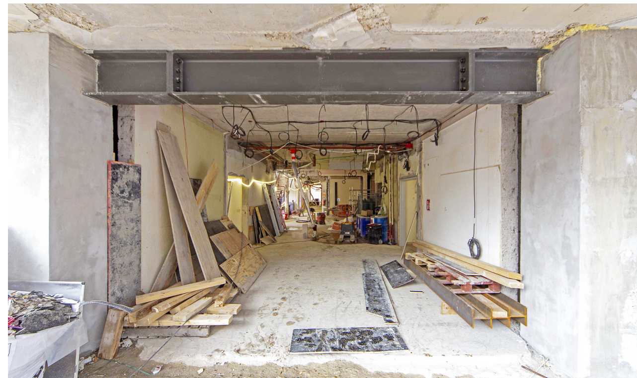
L'ouverture de la nouvelle entrée entre deux refends béton. Une poutre transmet la charge de la nouvelle salle aux fondations existantes. Pas de nouvelles fondations.
