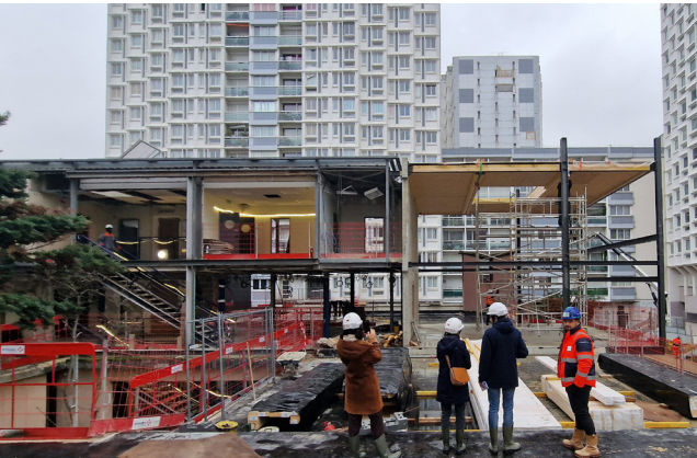
2024, la structure existante, le mur acoustique et la nouvelle structure.
