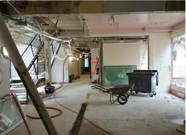
2023, après curage l'escalier apparaît, sa trémie sera allongée
