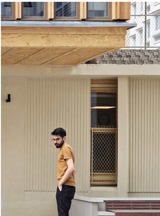
Les grilles reprennent le motif "square parisien" des gardes corps."
