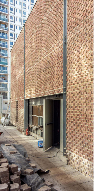
Dalles gravillonnées retournées en pied de façade.
