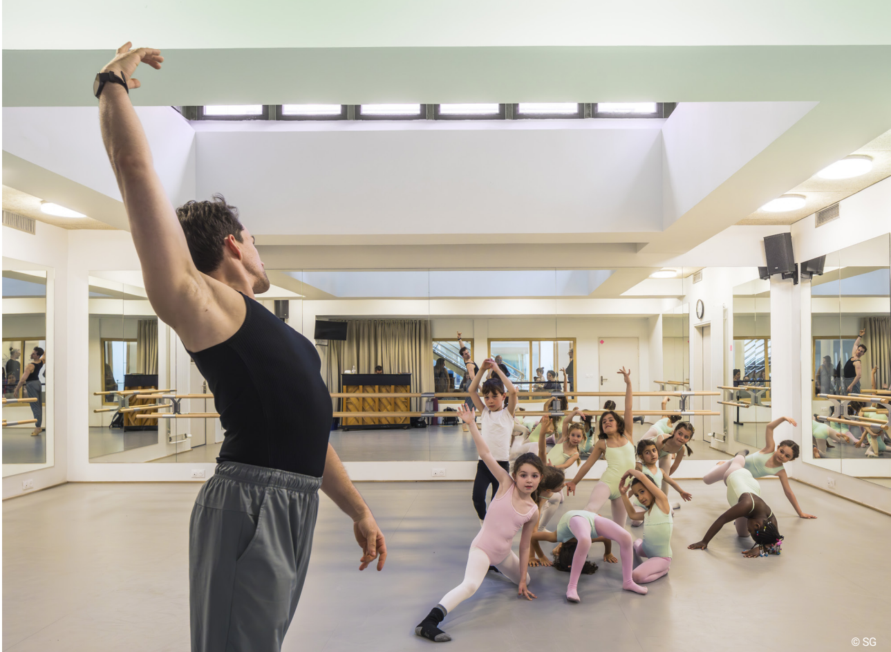
Le lanterneau de la nouvelle salle de danse, lui apporte lumière naturelle, ventilation et une ampleur bienvenue dans un rez-de-chaussée tenu par l'existant.
