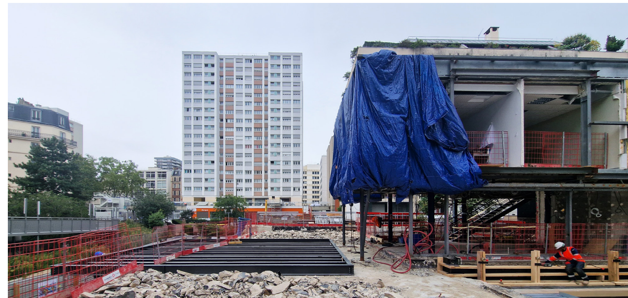
La console en acier de la salle d'orchestre à côté de la structure existante.
