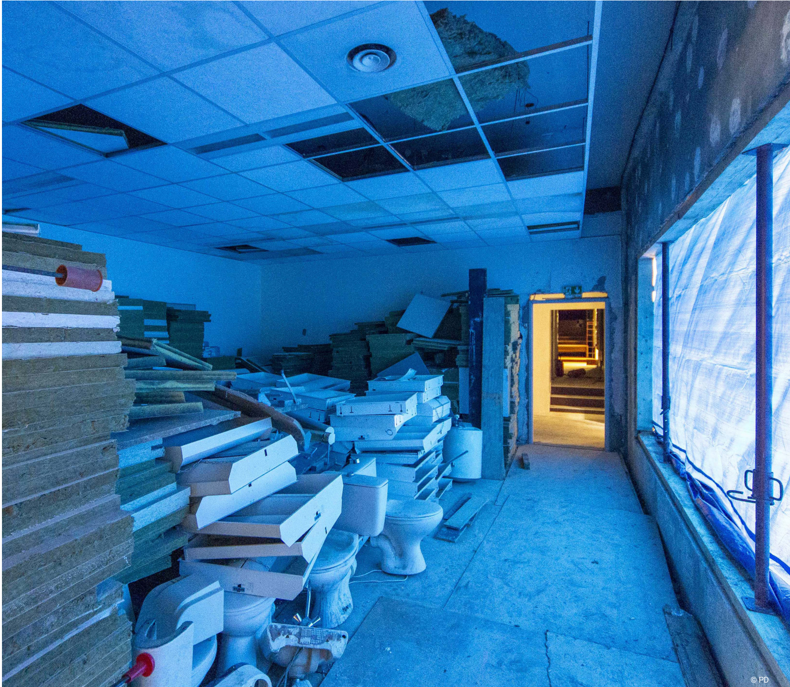
De tout ce stock seuls les sanitaires seront remis en place. Les luminaires à fluo, c'était une mauvaise idée. Les faux plafonds disparaîtront subitement.
