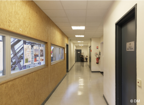
2020, le futur hall est encore un couloir, on accède à l'étage du dessus
