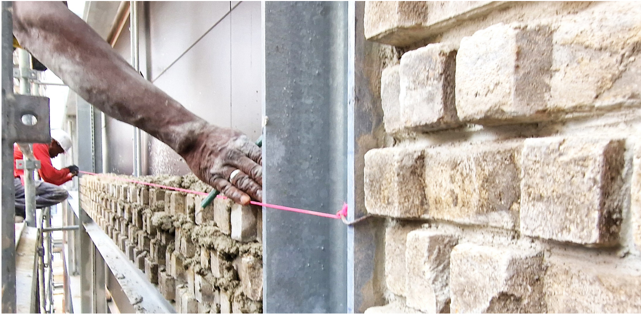
Le chaînage horizontal est rempli de demi-pavés, l'entraxe entre les chaînages a été modélisé pour tomber "juste" et ça a bien marché à l'horizontale et à la verticale.
