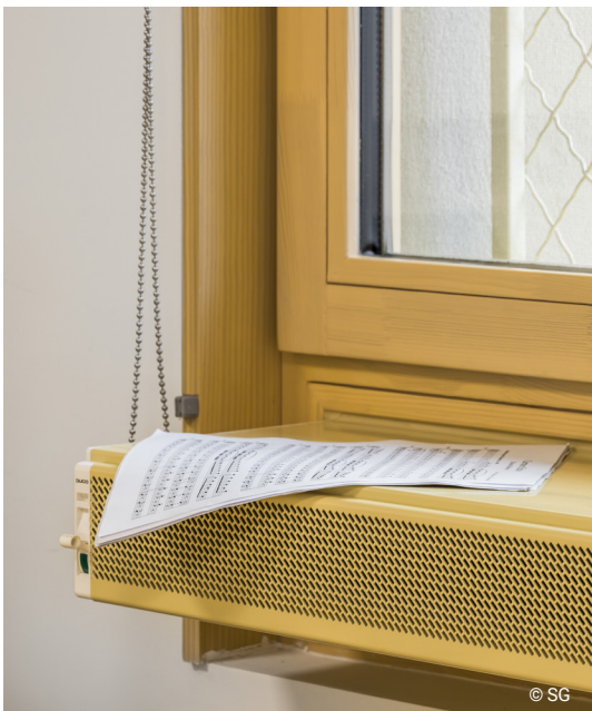
La ventilation naturelle passe par de larges pièges à sons.
