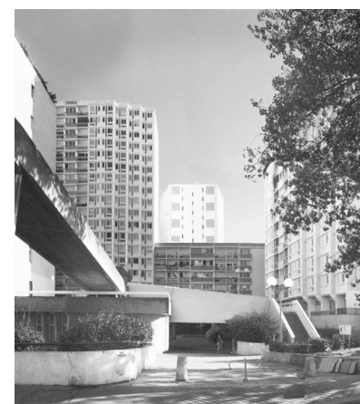
1976, accès depuis la rue Bargue par un petit escalier.
