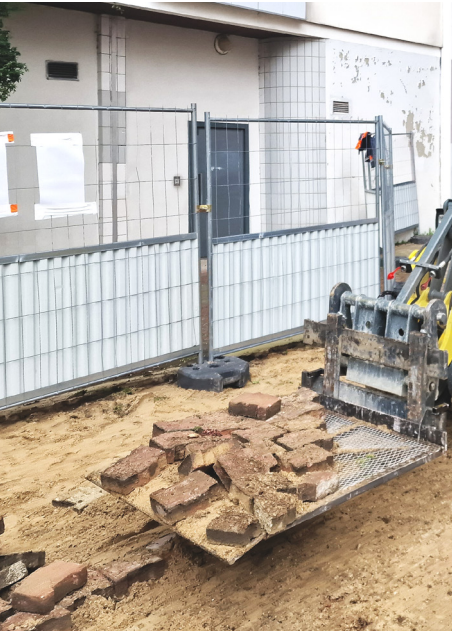
Dépose des pavés sur lit de sable.
