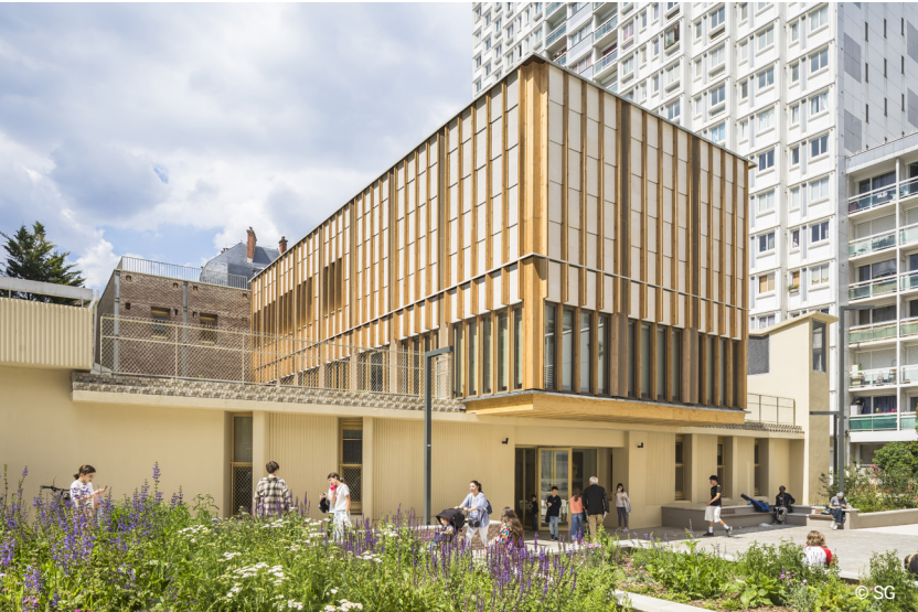
Un an de travail pour éviter ce déflecteur qui n'aurait eu aucune utilité technique.
