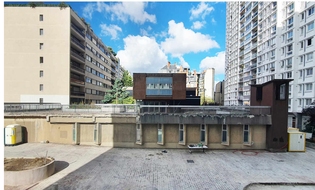
Après les démolitions, le bâtiment se révèle, c'est un vaste rez-de-chaussée avec des constructions en toiture.
